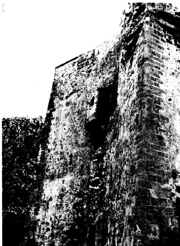
**FIG. 28. La torre di Calazza Cofano, dalle pareti concave, per facilitare lo slittamento delle palle di cannone e diminuirne l'impatto.**
